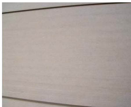
Stav povrchu terasy po očištění tlakovou vodou a po vyschnutí.
